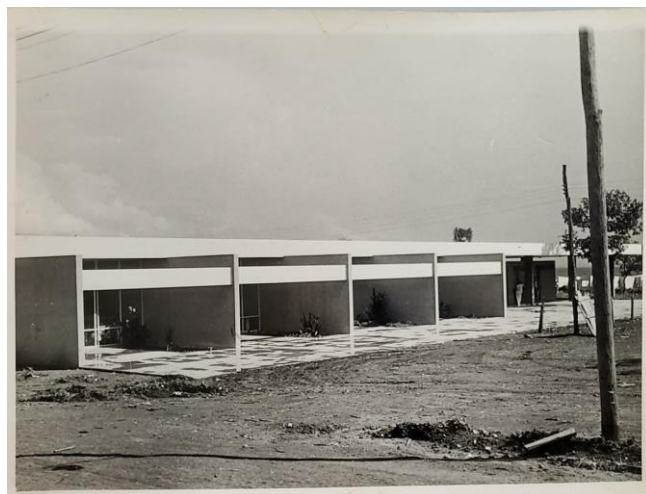
Foto da Escola Recém Construída
